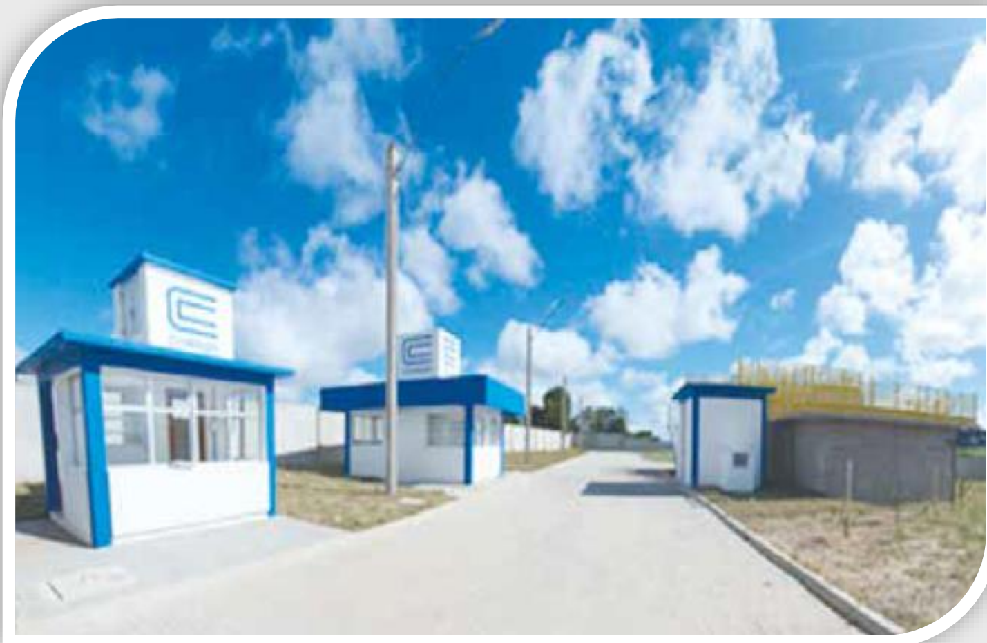
Pedras Altas – nova ETE
