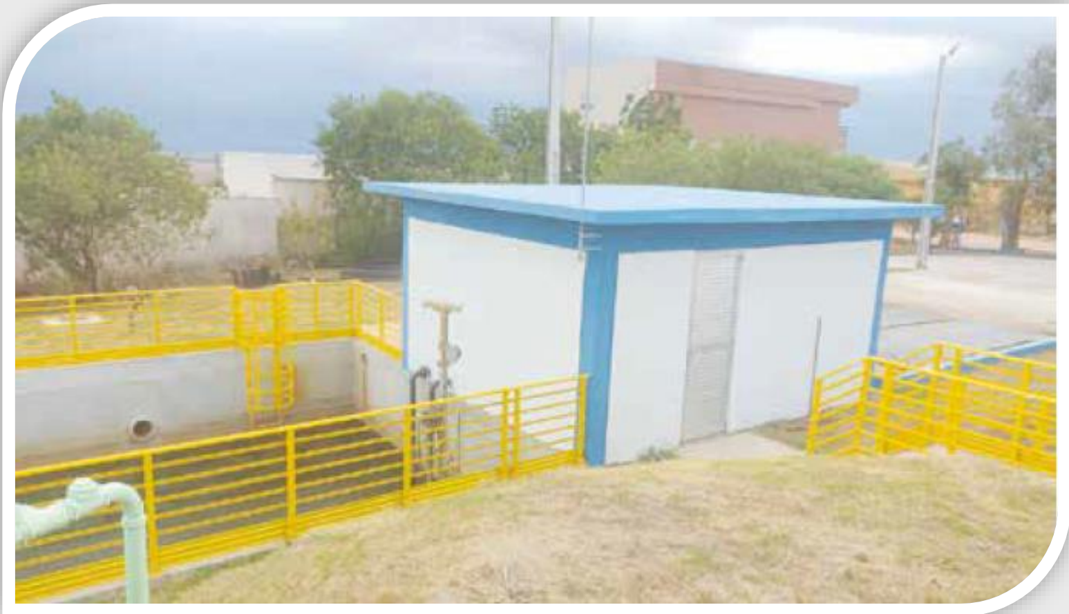
Aceguá – novo Sistema de desaguamento de lodo da ETA
